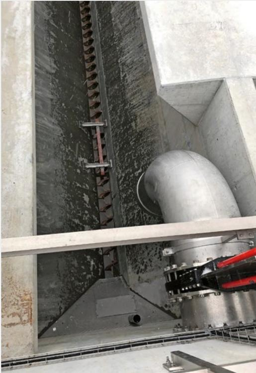
Fig. 6 Blick von oben auf das Zulaufrohr und die Förderschnecke.
