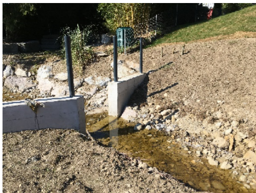
Rechen und Dämme Am Kaabach (Kt. Thurgau) wurde die Hochwassergefahr mit einem Geschieberückhalt und einem Schwemmholzrechen reduziert.
