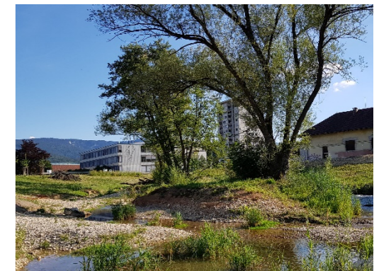
Delémont Marée Base Mit dem realisierten HWS – und Revitalisierungsprojekt in der Stadt Delémont wurde die HWS- Gefahr entschärft und ein attraktives Erholungsgebiet geschaffen.
