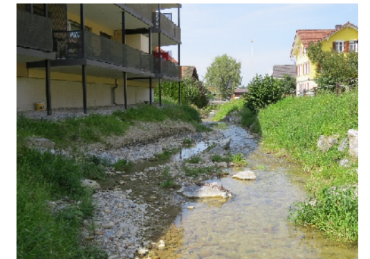
Revitalisierung im Siedlungsraum Mit Ausdolungen und Aufwertungen von Gewässern wird ein attraktiver Ort für die Bevölkerung geschaffen.
