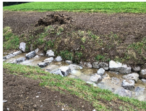
Schwellen und Blockrampen Am Sacktobelbach (Kt. Zürich) wurden die Sohle und die Ufer stabilisiert und die Fischdurchgängigkeit wieder hergestellt.
