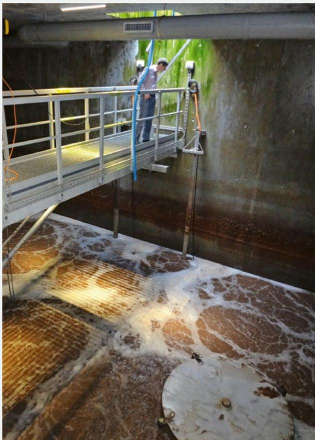
Fig. 3 Anammox-Anlage der ARA Bern, die erste Schweizer Vollmassstabsanlage, die von der einstufigen Betriebsweise zur zweistufigen gewechselt hat und dadurch die höhere Betriebsstabilität bestätigte.
