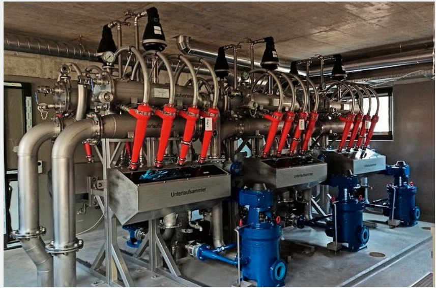
Fig. 5 Hydrozyklon des S::Select-Verfahren mit granulärem Schlamm.
